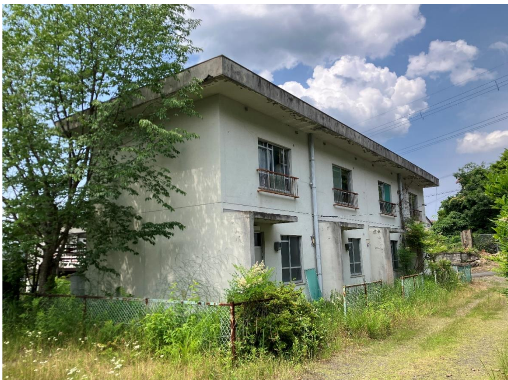
附属建物符号1(北棟) 西側より撮影
