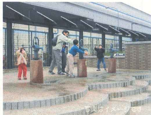
公園の耐震性貯水槽
