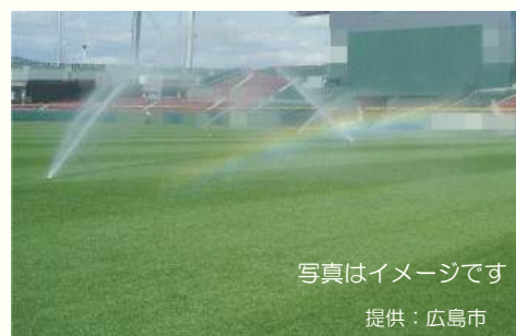
雨水を利用した芝散水
