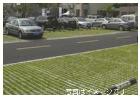
透水性舗装（緑化舗装）
