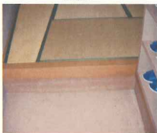
宿泊室入口の段差
