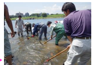
▲簡易な魚道(鴨川)と設置作業の様子
