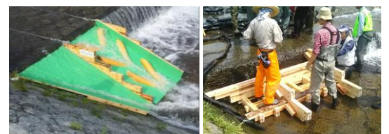
▲簡易な魚道(鴨川)と設置作業の様子
