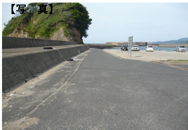
【浅茂川漁港】臨港道路 終点側
