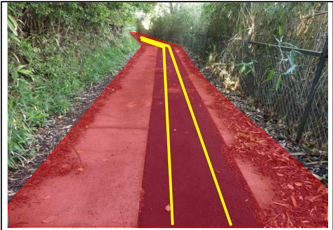
伊根地区飲雑用水（舗装本復旧）
