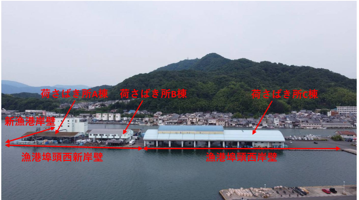
舞鶴漁港 整備対象施設全景
