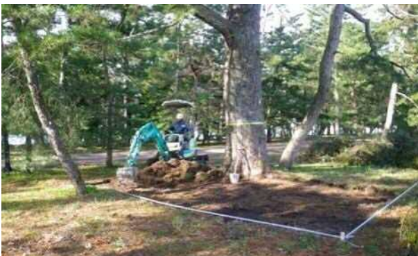
①重機にて表層腐植層のかきとり
