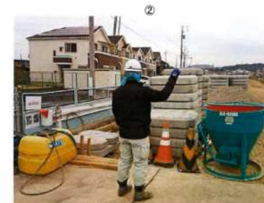
クレーンオペレーターに合図
