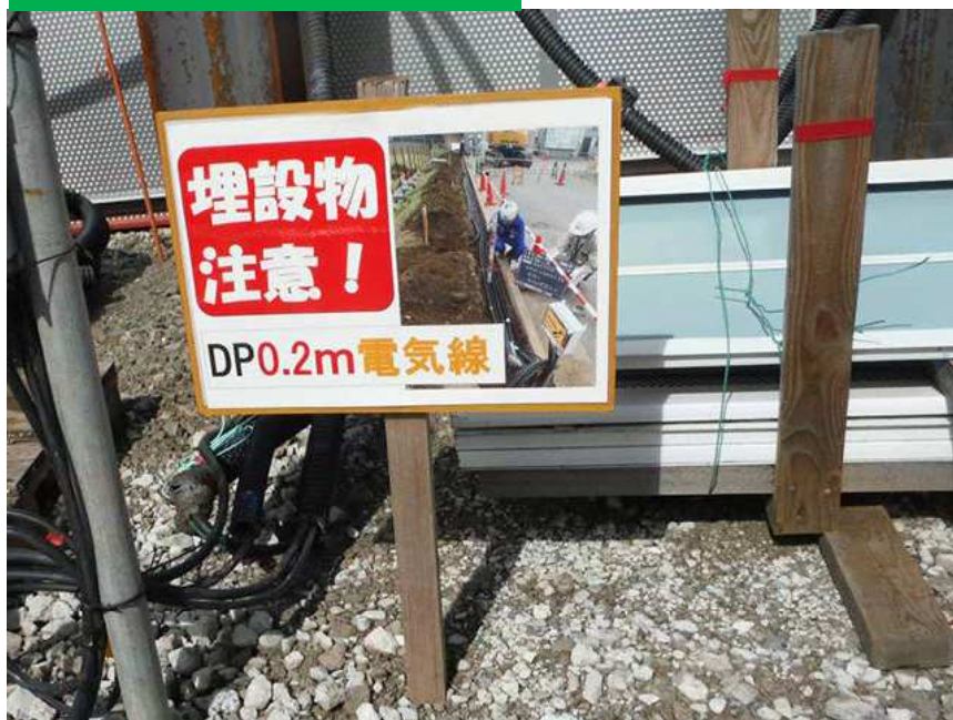
埋設管の明示板の設置
