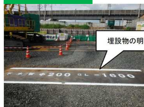
埋設管の明示
