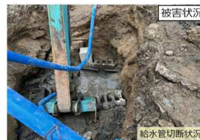
給水管切断状況
