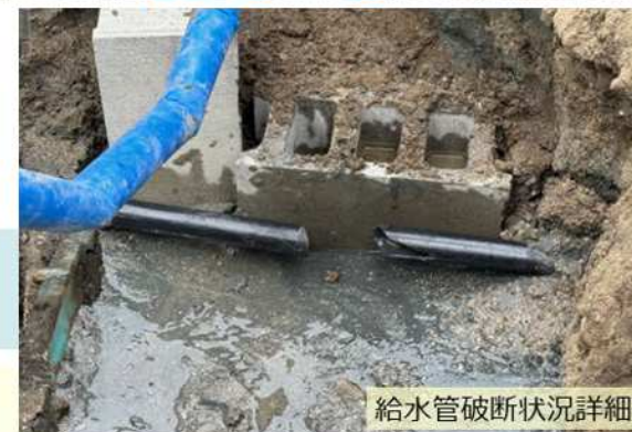
給水管切断状況
