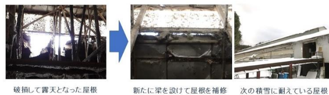
図20. 大雪被害で陥没した鶏舎屋根の応急処置
