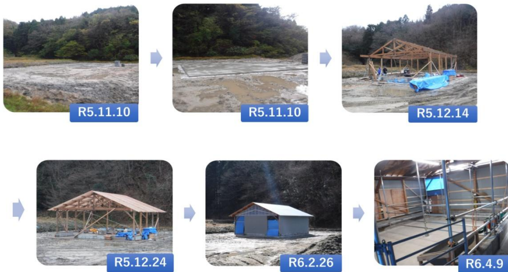
図6. 牛舎の自力施工
