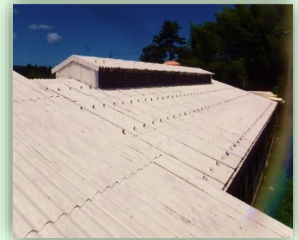
畜舎屋根へ石灰塗布することで直射日光の影響が緩和されます
