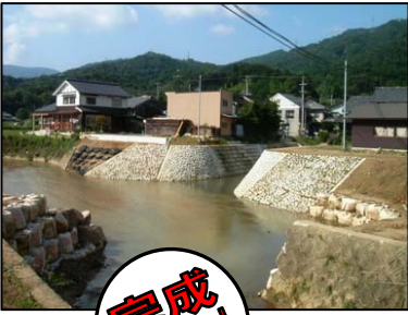
柿ヶ成川の護岸工事 砂後建設
