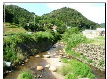
新中橋下流護岸工事 藤照工業 工事着手に向けて準備をしています。
