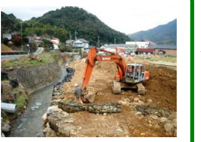
新中橋下流護岸工事 藤照工業 右岸側の護岸工事をしています
