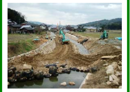
生野神社橋上流 西口工業 右岸側の工事をしています
