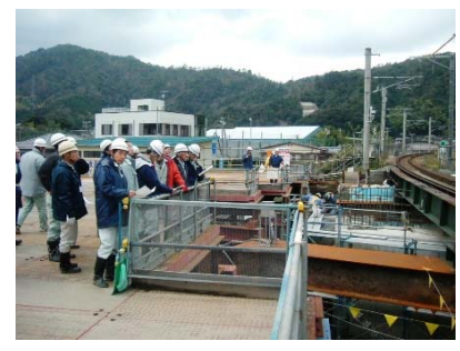
KTR宮津川橋梁架け替え工事 大鉄・金下JV 橋脚を作っています
