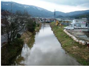
松原橋下流左岸工事 カヤ興産 工事着手に向けて作業しています
