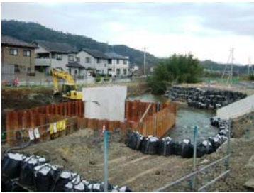
百合が丘橋架け替え工事 金下・きしべJV ご迷惑をお掛けしています 現在、通行止めです
