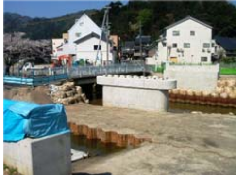
京口橋架け替え工事 極東興和 マルキ・大建JV 上部工、護岸工事に着手します
