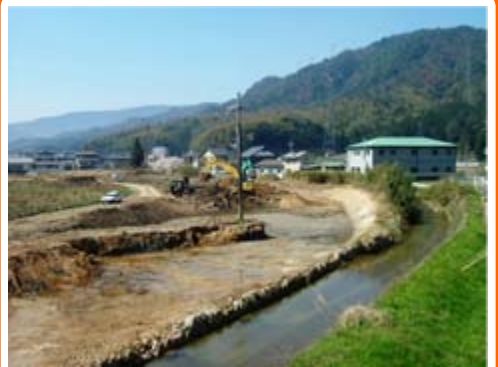
新松原橋上流 河守工業 川幅を広げ掘り下げる工事をしています
