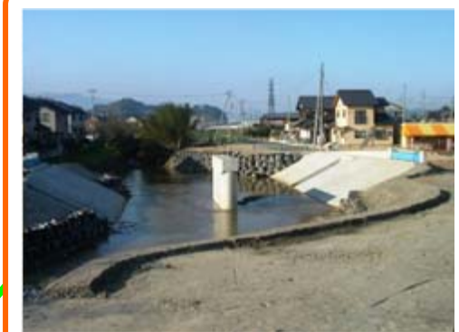
百合が丘橋架け替え工事 金下・きしべJV 下部工が完成しました
