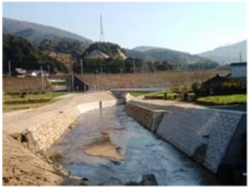
生野神社橋上流 西口工業 左岸右岸護岸工事完成しました
