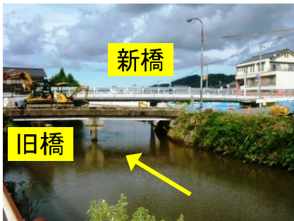
↑下流より京口橋を望む
