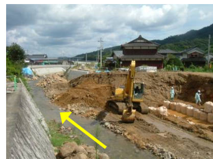
↑上流より生野神社橋工事現場を望む
