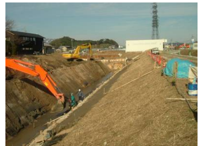
↑鮎川団地裏より下流を望む
