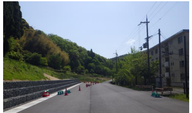
R4工事箇所
