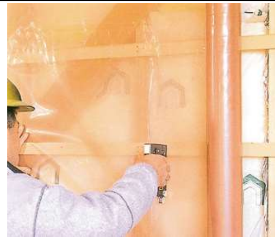
防湿気密シートの施工
