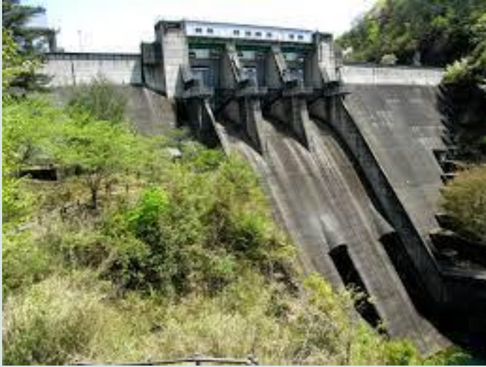
【水力】大野発電所 (11,000kW)
