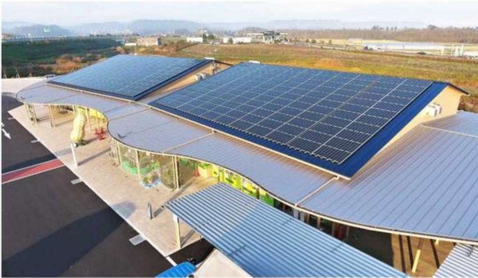
写真出所) スマートソーラー 導入事例「道の駅木更津うまかつの里」 https://www.smartsolar.co.jp/case/5353/ （閲覧日：2020/11/26）
