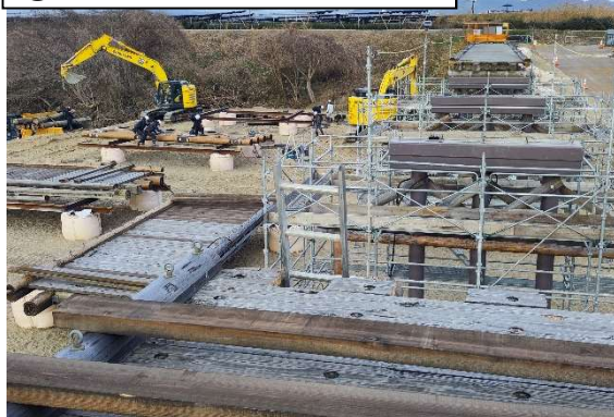
③上部工組立・下部工修繕
