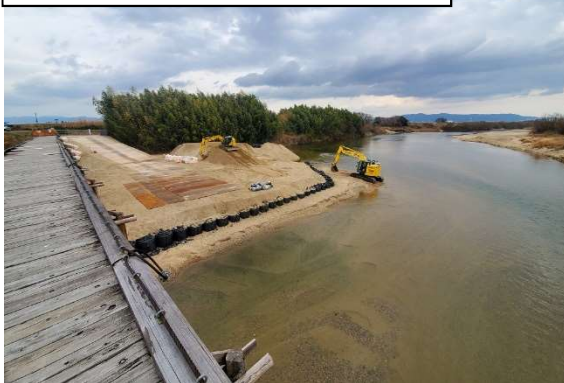
①流路付替・施工ヤード築造
