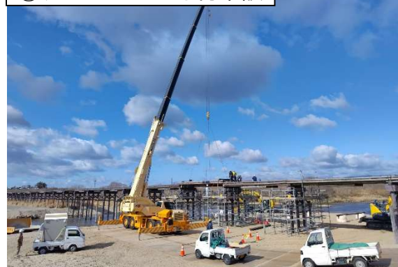
④クレーンによる再架設
