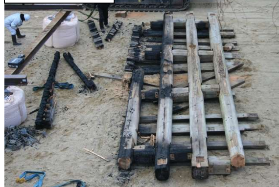
②上部工解体
