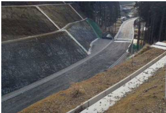
施工の状況（切土部）
