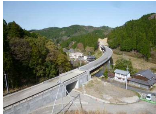
施工の状況（奥山田2号橋）
