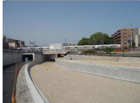
施工の状況（JRアンダーパス部）
