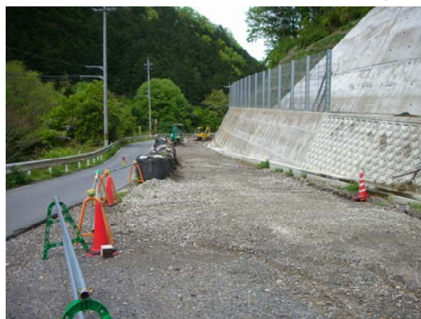
工事進捗状況
