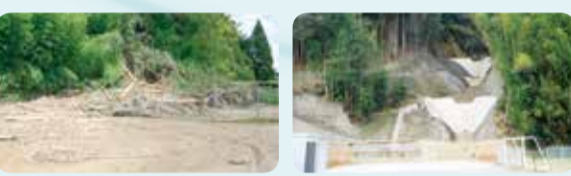
被災直後 復旧後
