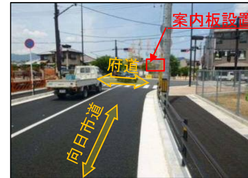
向日市道から交差点正面を撮影
