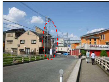
橋の左岸側交差点にある既存道路照明 (西側から撮影)
