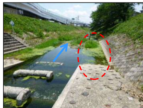
上流側から撮影
