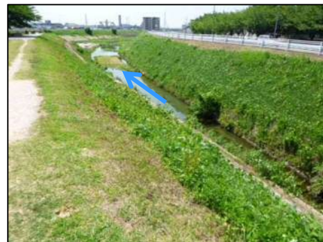
上流側から撮影
