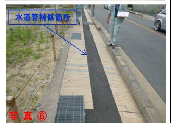
備考 一部区間（水道管補修箇所）は、アスファルト舗装とする予定。今回確認した危険箇所を含め、今後は維持修繕で現況のタイル舗装をアスファルト舗装で補修することとする。
