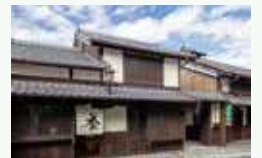
景観重要建造物に指定された店舗外観。カフェは通路の奥にあります。
