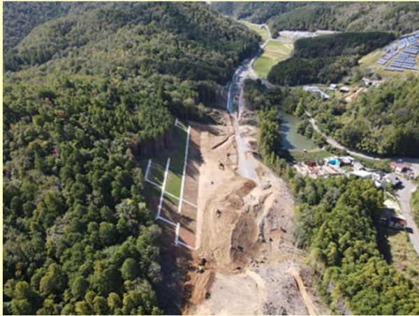
国道423号(法貴バイパス) 【亀岡市】
