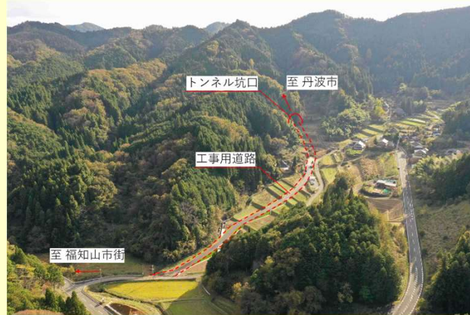
国道429号(榎峠バイパス) 【福知山市】
