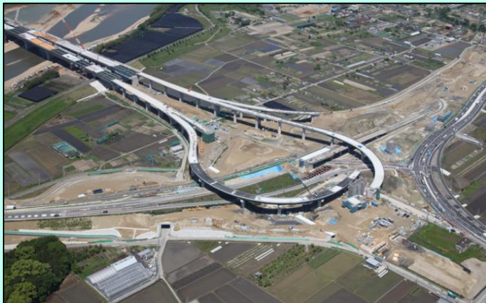
建設中の城陽ジャンクション
