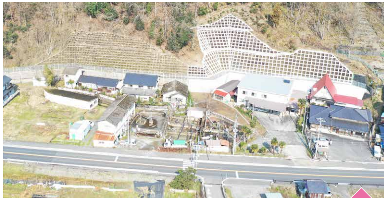
下小田(福知山市) 山の斜面に「ようへき工」「のり砕工」をつくり、家や国道9号を守っています。
