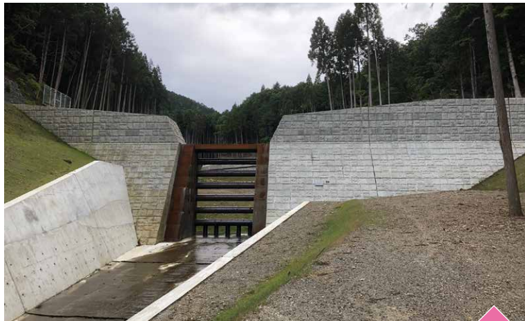
さ ぼうえんてい 花尻川砂防堰堤(京都市左京区) 砂防堰堤により、土砂災害から、病院などを守っています。
